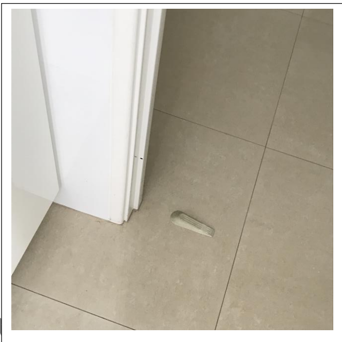
4.10.1b. Missing door frame buttons
